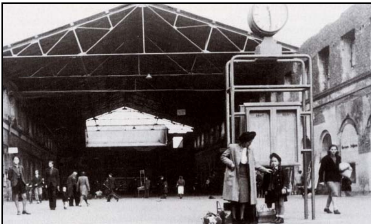
Bild 3: Das beschädigte und teilweise abgerissene Bahnhofsgebäude nach provisorischer Wiederherstellung um 1955.
