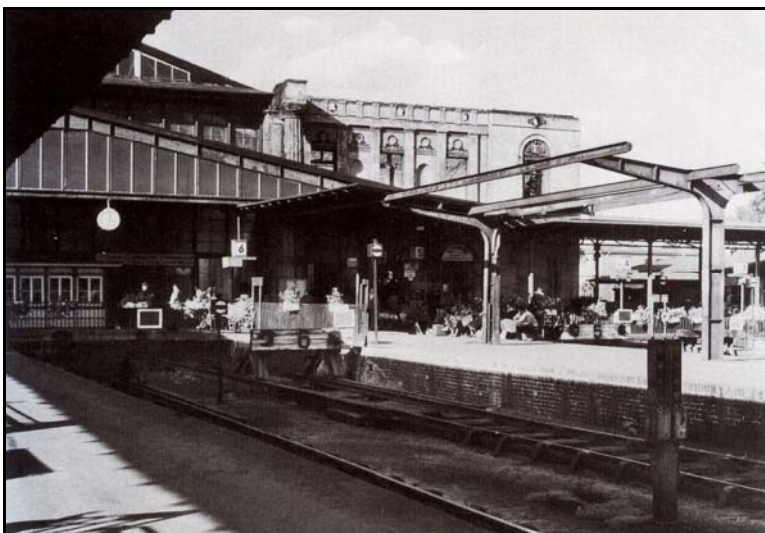
Bild 4: Der Bahnhofsbetrieb nach teilweiser Wiederherstellung des Bahnhofs 1960 - im letzten Jahr seines Bestehens.
