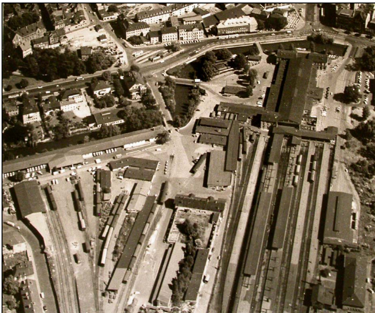
Bild 5: Hauptbahnhof und linksseitig das Holzhofgelände mit Postbaracken - 1959
