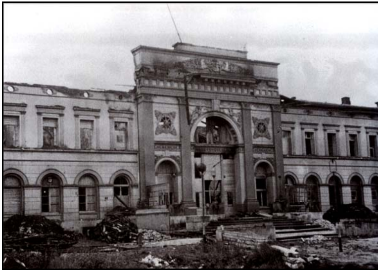
Bild 2: Das Bahnhofsgebäude (Ottmerbau) nach Bombentreffern 1944.
