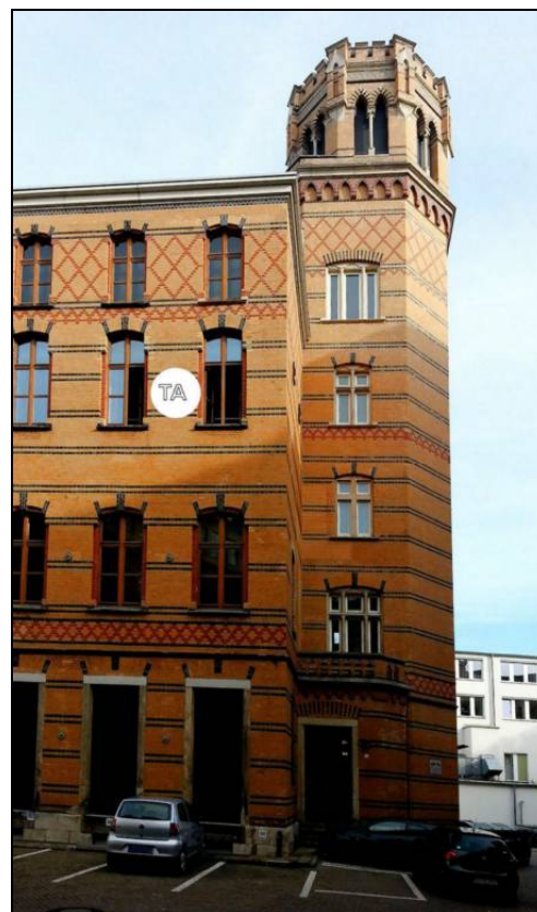
Bild 42: Im 2. OG befand sich der Fernsprechdienst und die Telegraphenstation. Im Turm das Treppenhaus.
