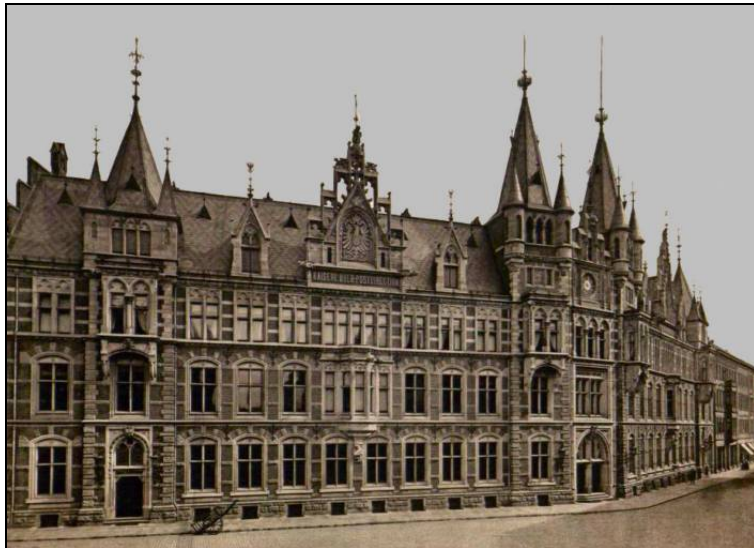
Bild 29: OPD-Gebäude, in der Friedrich-Wilhelm-Straße ca. 1880/81
