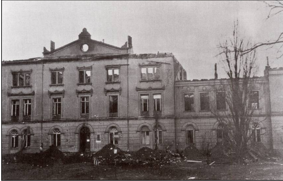
Bild 54: Zerstörtes Direktionsgebäude (Claudia A. Gronen)
