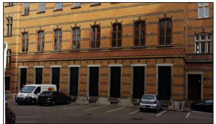
Bild 34: Das Gebäude links - 2018
