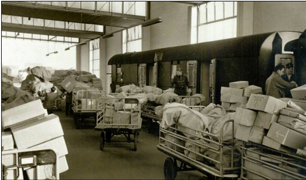
Bild 34: Aufnahmeort Postbahnhof Gleis 302 Handentladung
