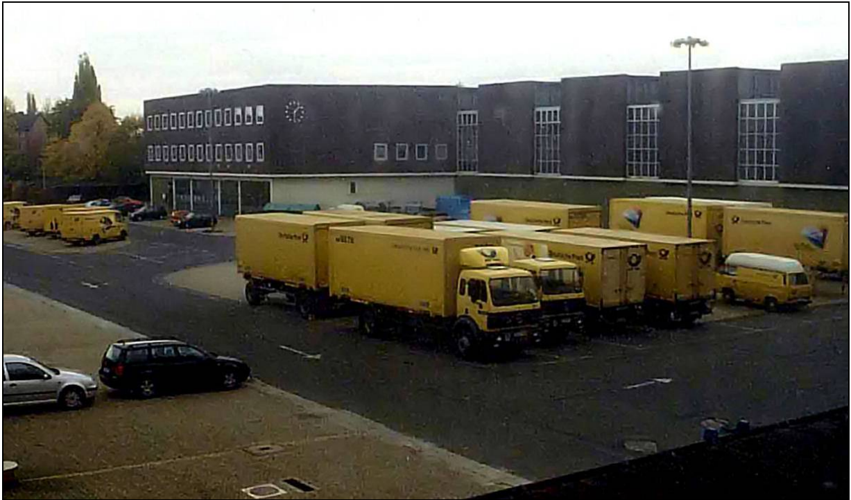
Bild 13: Das Bahnpostdienststellengebäude vom Post-Betriebsgebäude aus gesehen (Stadtarchiv Braunschweig H XXVIII: 86 Akz. 2008/135)
