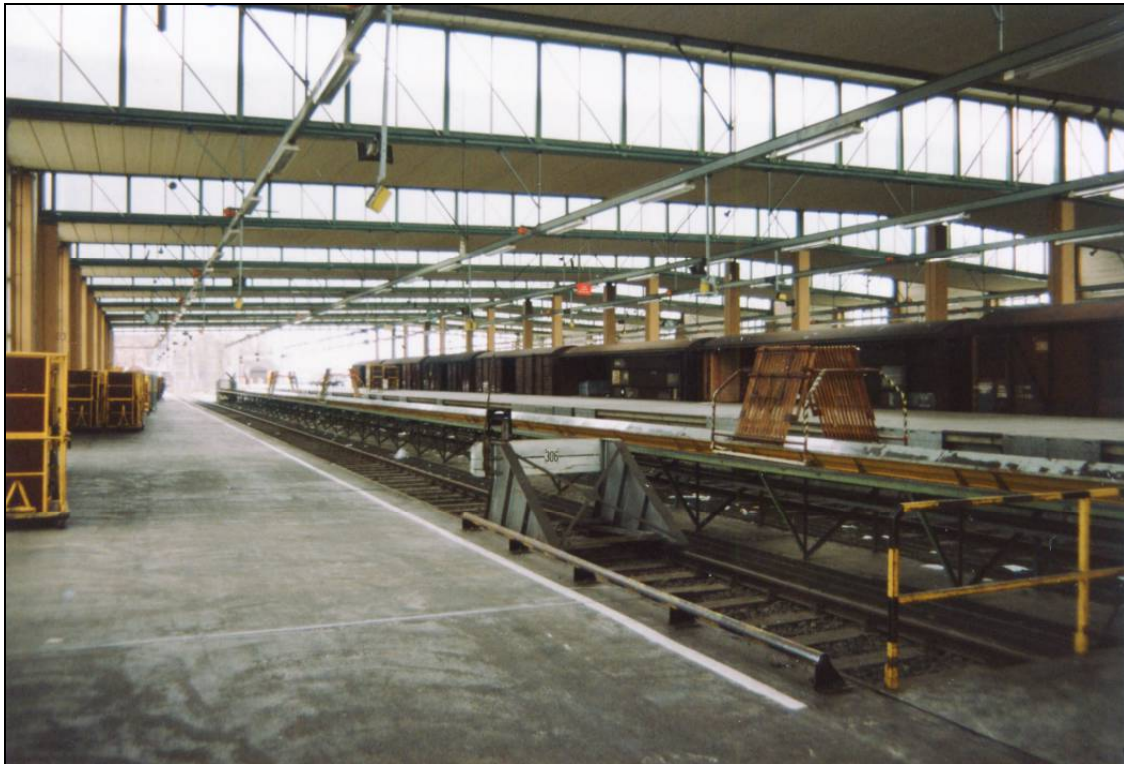
Bild 16: Das Entladegleis 306, rechts neben dem Gleis ist das Entladeband zu erkennen, es befindet sich zwischen Gleis 306 und 305 (Foto K. Tasche)
