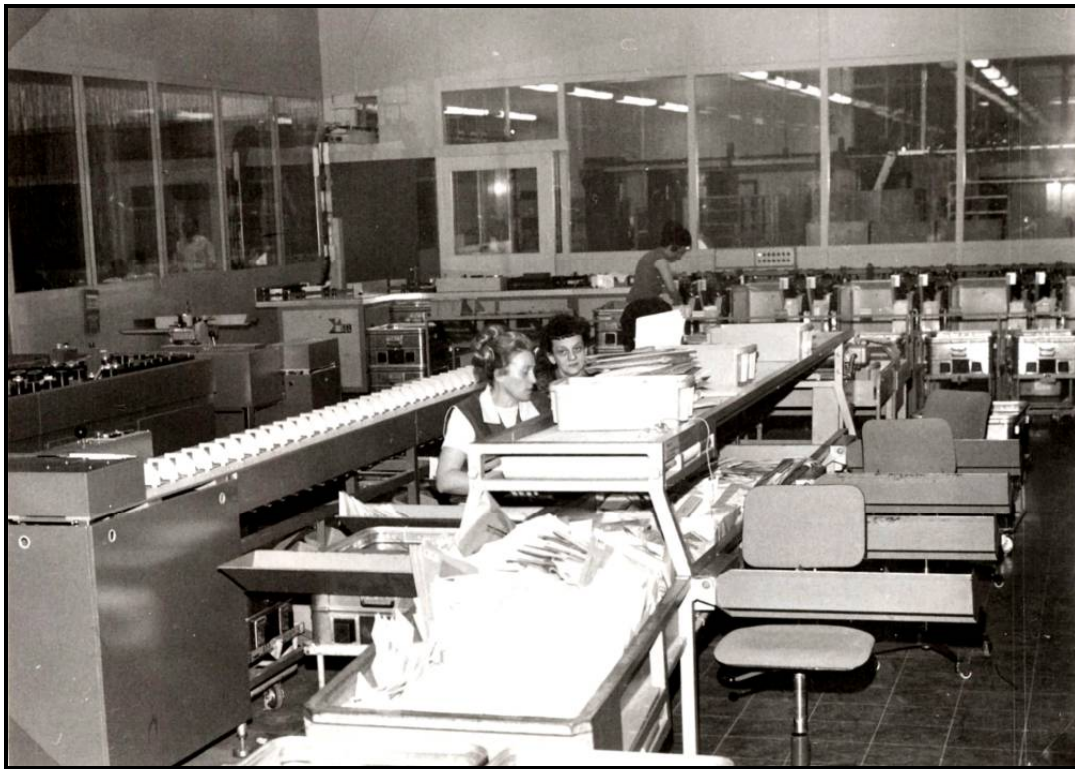
Bild 6: Briefordnerei – rechts Formattrennung, links Briefaufstellung und Stempelung, hinter der Formattrennung, vor der Glaswand, steht die SEL Verteilmaschine VM 10.
