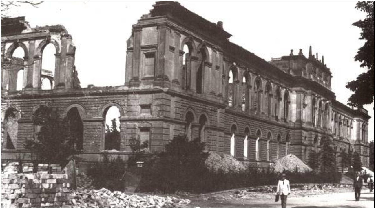
Bild 65: Das Hauptgebäude der Carolo-Wilhelmina wurde völlig zerstört. (aus BAUKULTUR Jahrgang 6/1981)
