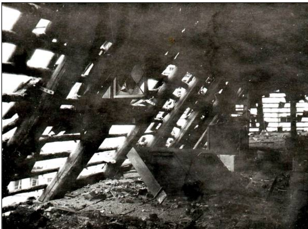
Bild 38: Der Dachstuhl nach dem Bombentreffer (Dr. W. Bohlmann)
