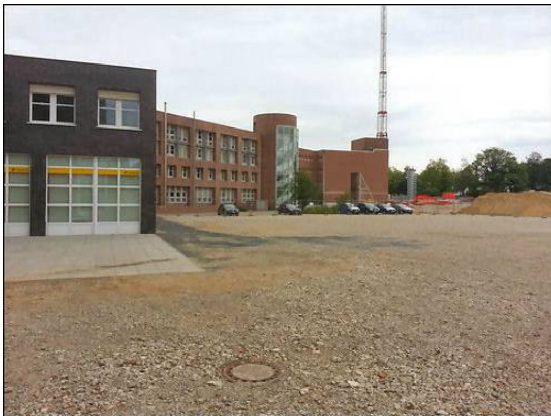
Bild 58: Blick vom Standort des ehemaligen Betriebsgebäude auf die noch vorhandenen Verwaltungsgebäude - Juni 2014.
