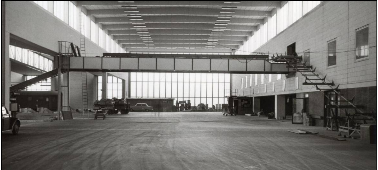
Bild 52: Die Kopfbahnsteighalle kurz vor dem Abriß (Foto K. Tasche)
