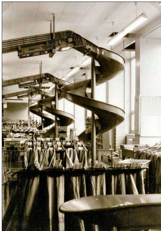
Bild 31: Versackstelle im 1. OG - Briefpostzuführung über Bundeanlage von der Briefverteilung (BVA) aus dem 2. OG. (Stadtarchiv Braunschweig H XXVIII: 87 Akz. 2008/135)
