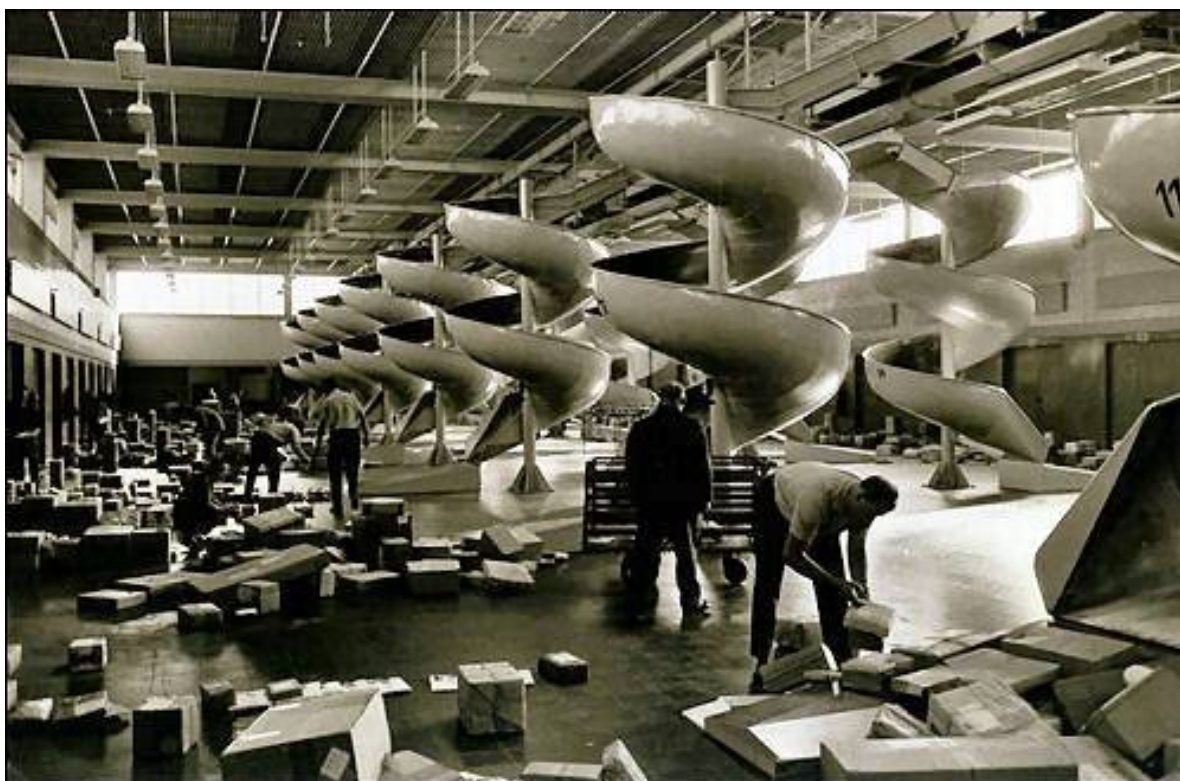
Bild 44: Paketverteilband und Wendelrutschen in der Ortspackkammer (Stadtarchiv Braunschweig H XXVIII: 87 Akz. 2008/135)
