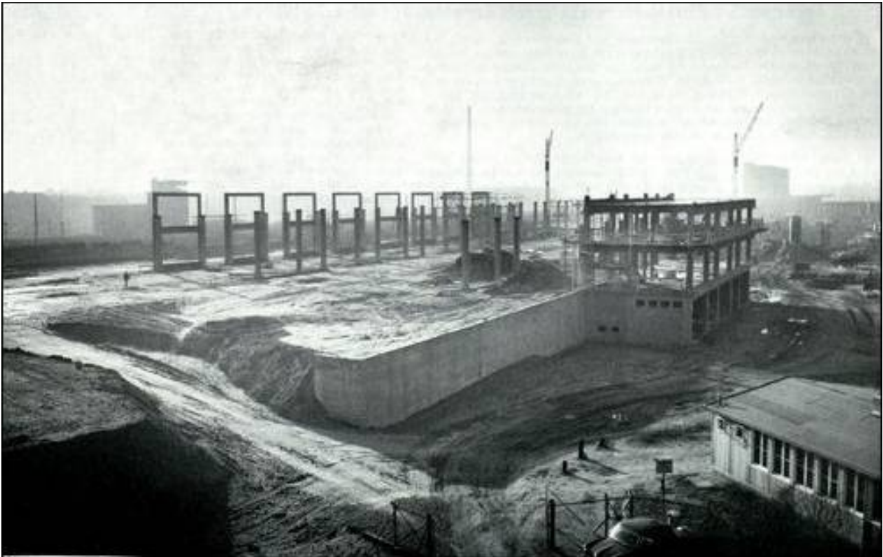
Bild 4: Postbahnhof 1. Bauabschnitt - Baustand Nov. 1959 (Stadtarchiv Braunschweig H XXVIII: 86 Akz. 2008/135)
