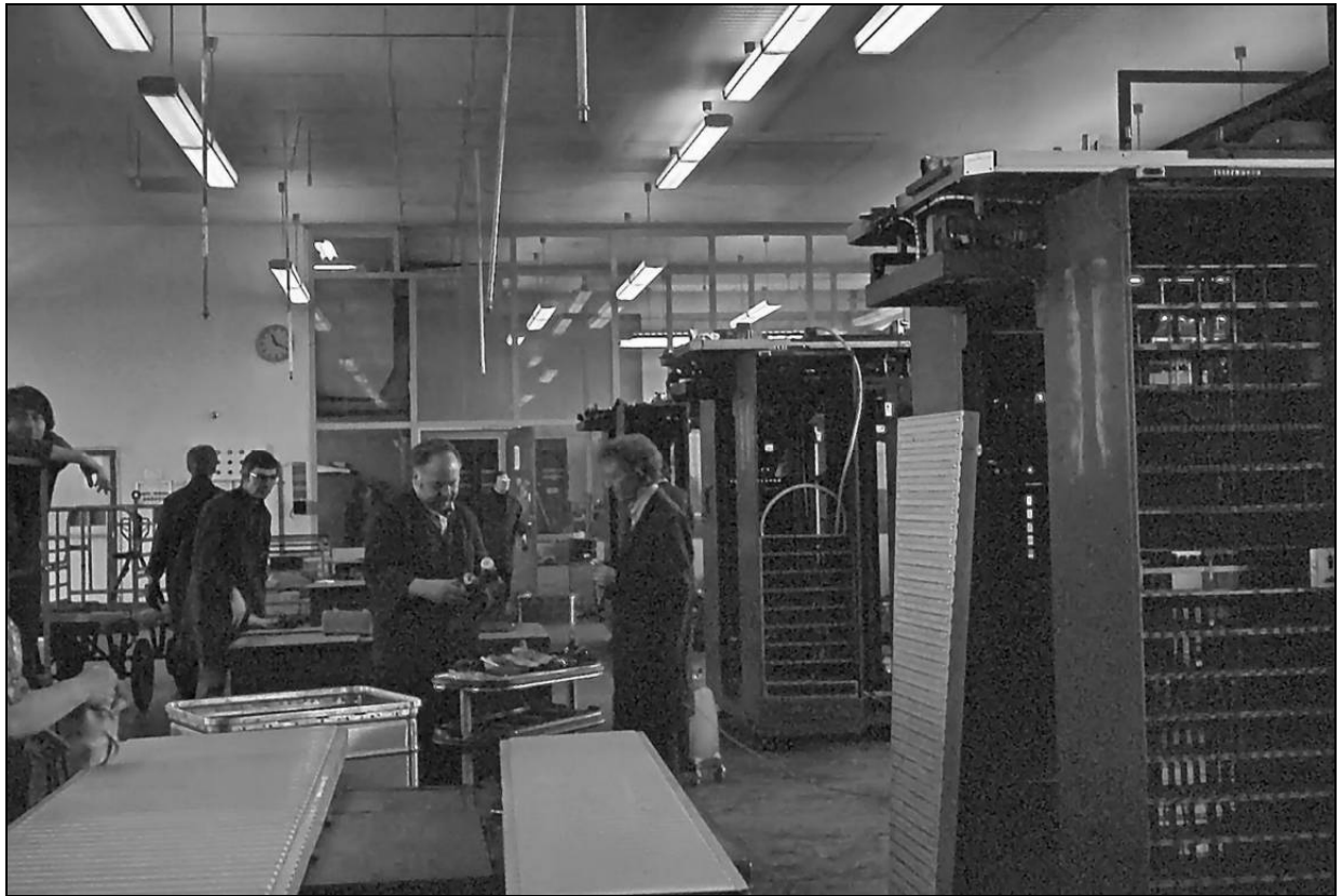
Bild 54: Die Feinverteilmaschinen im Briefpostbetriebsgebäude werden demontiert (Foto K. Tasche)
