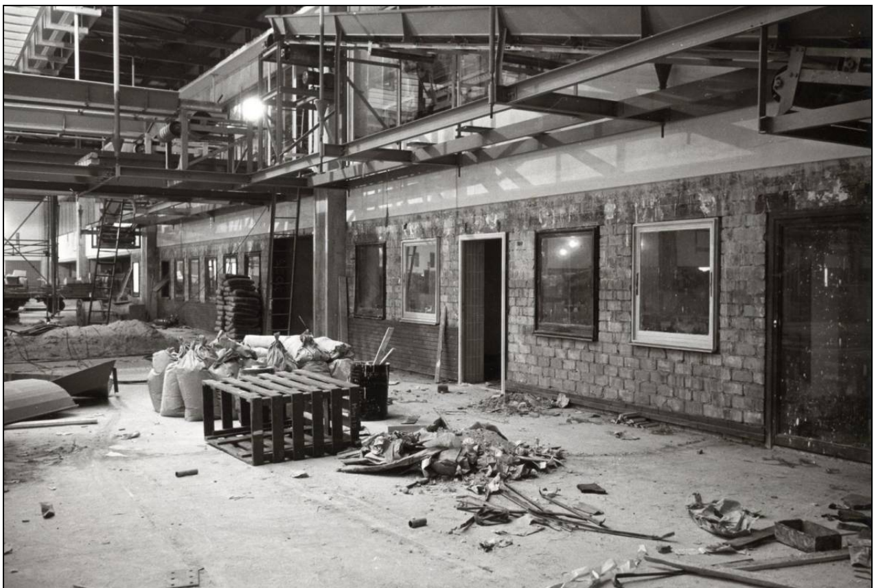
Bild 53: Die Kopfbahnsteighalle während der Abrißarbeiten (Foto K. Tasche)
