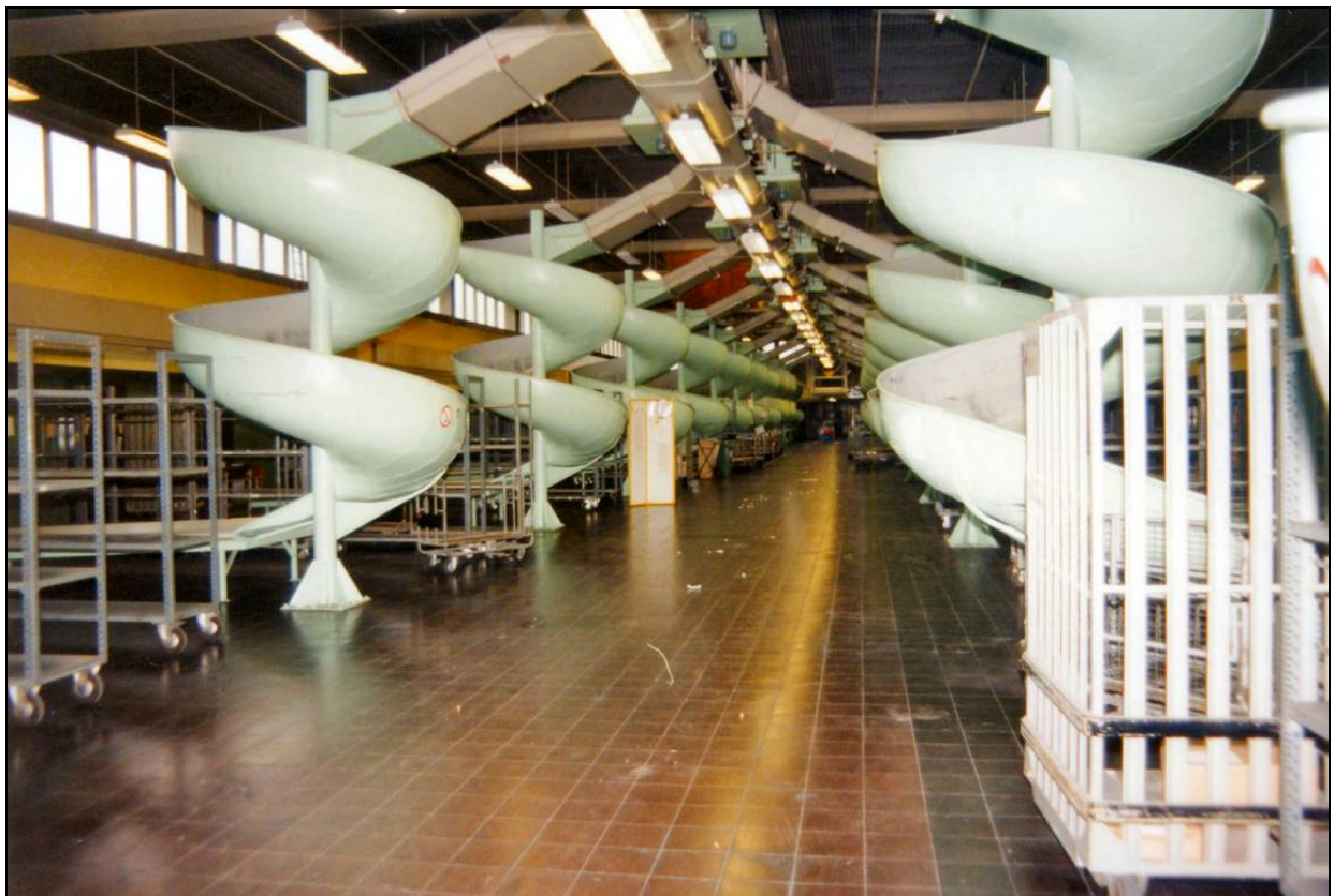
Bild 55: Die Ortspackkammer kurz vor der Demontage (Foto K. Tasche)
