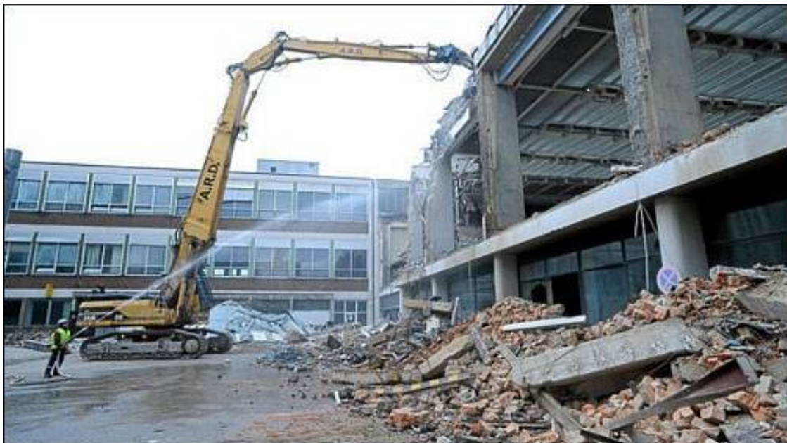
Bild 57: Abriß Ortspackkammer - im Hintergrund steht noch das Betriebsgebäude (Braunschweiger Zeitung)
