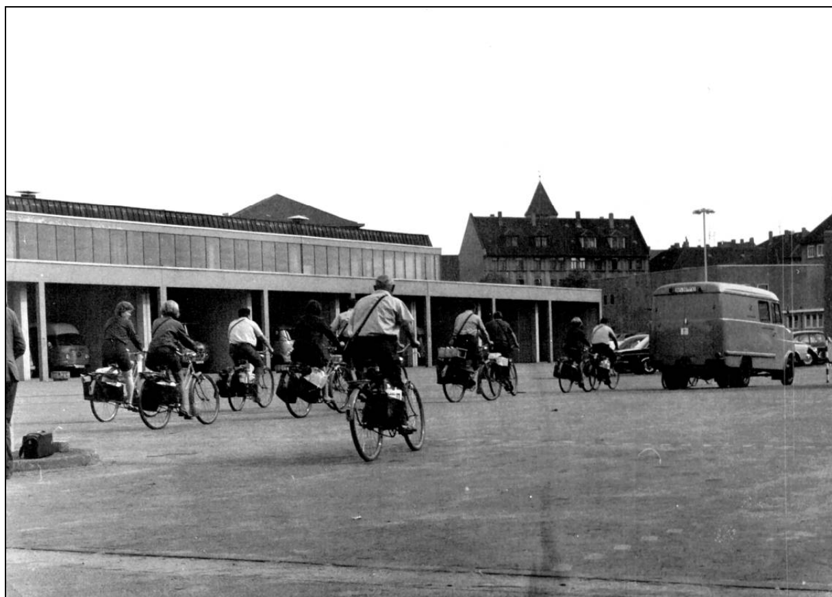
Bild 34: Entlang der Ortspackkammer in Richtung Rietschelstraße
