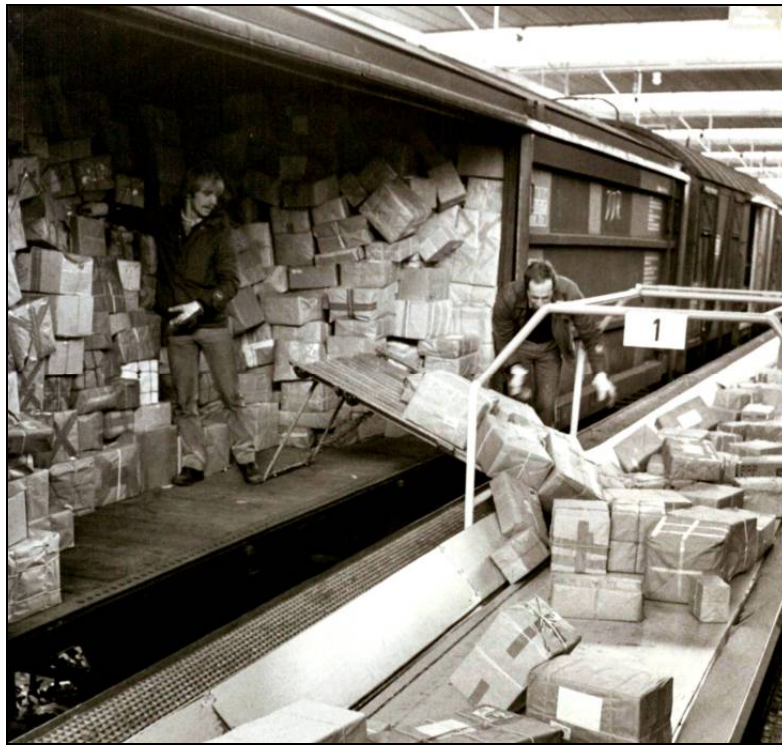
Bild 17: Bahnsteig Postbahnhof zwischen Gleis 306 u. 305 - Entladung mit Hilfe einer Rutsche auf die Förderstrecke, Blickrichtung in Richtung Einfahrt Postbahnhof (Stadtarchiv Braunschweig H XXVIII: 87 Akz. 2008/135)
