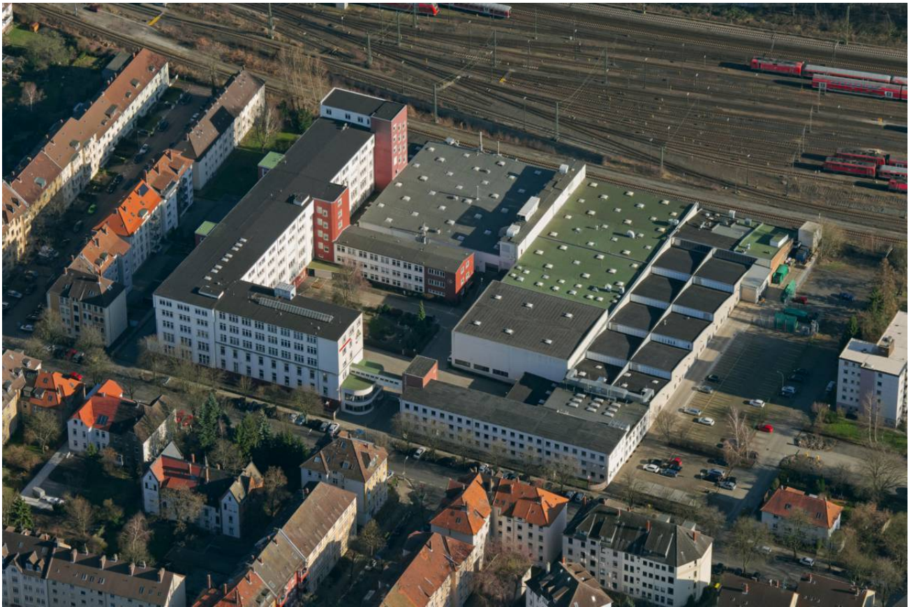
Bild 30: Verlags- und Produktionsgebäude 2016 (Westermann)
