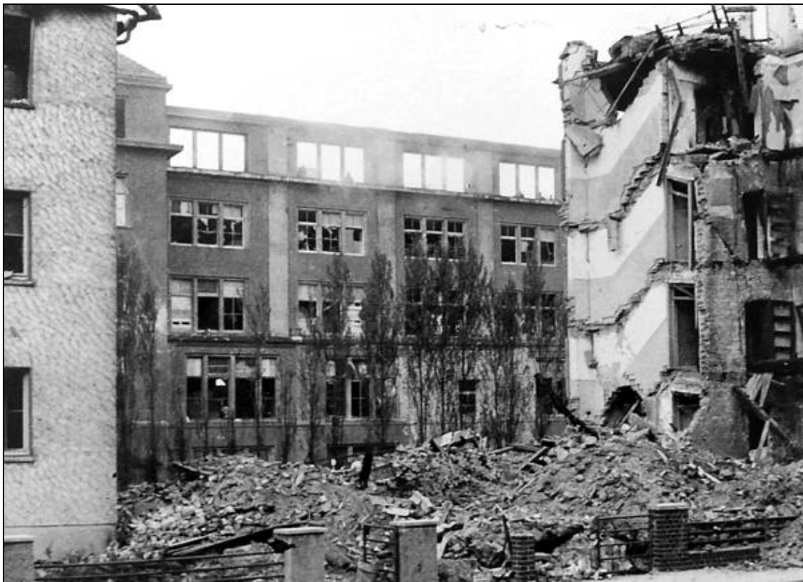
Bild 21: Ein Blick von der Griepenkerlstraße auf das zerstörte Verlagsgebäude - Nov. 1944 (Bild 20 u. 21 Archiv Westermann)
