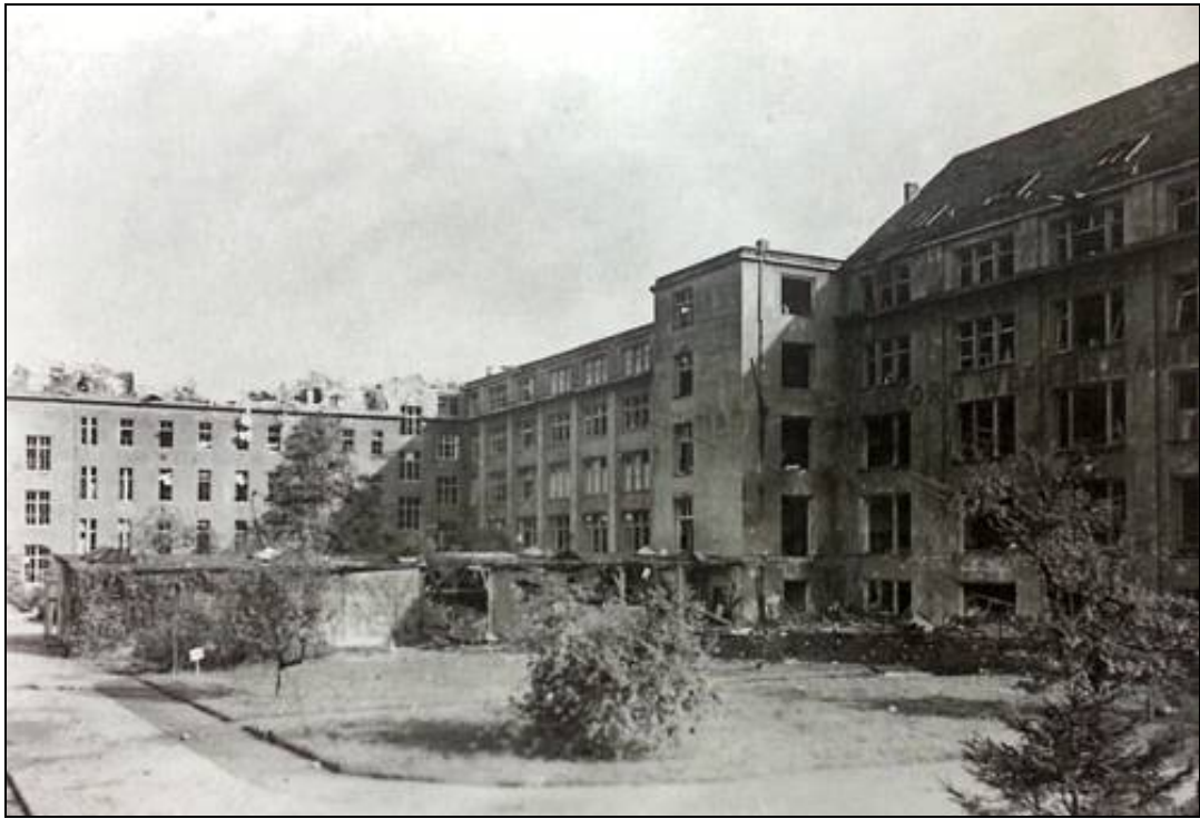
Bild 24: Das zerstörte Verlagsgebäude - vom Innenhof betrachtet (Archiv Westermann)
