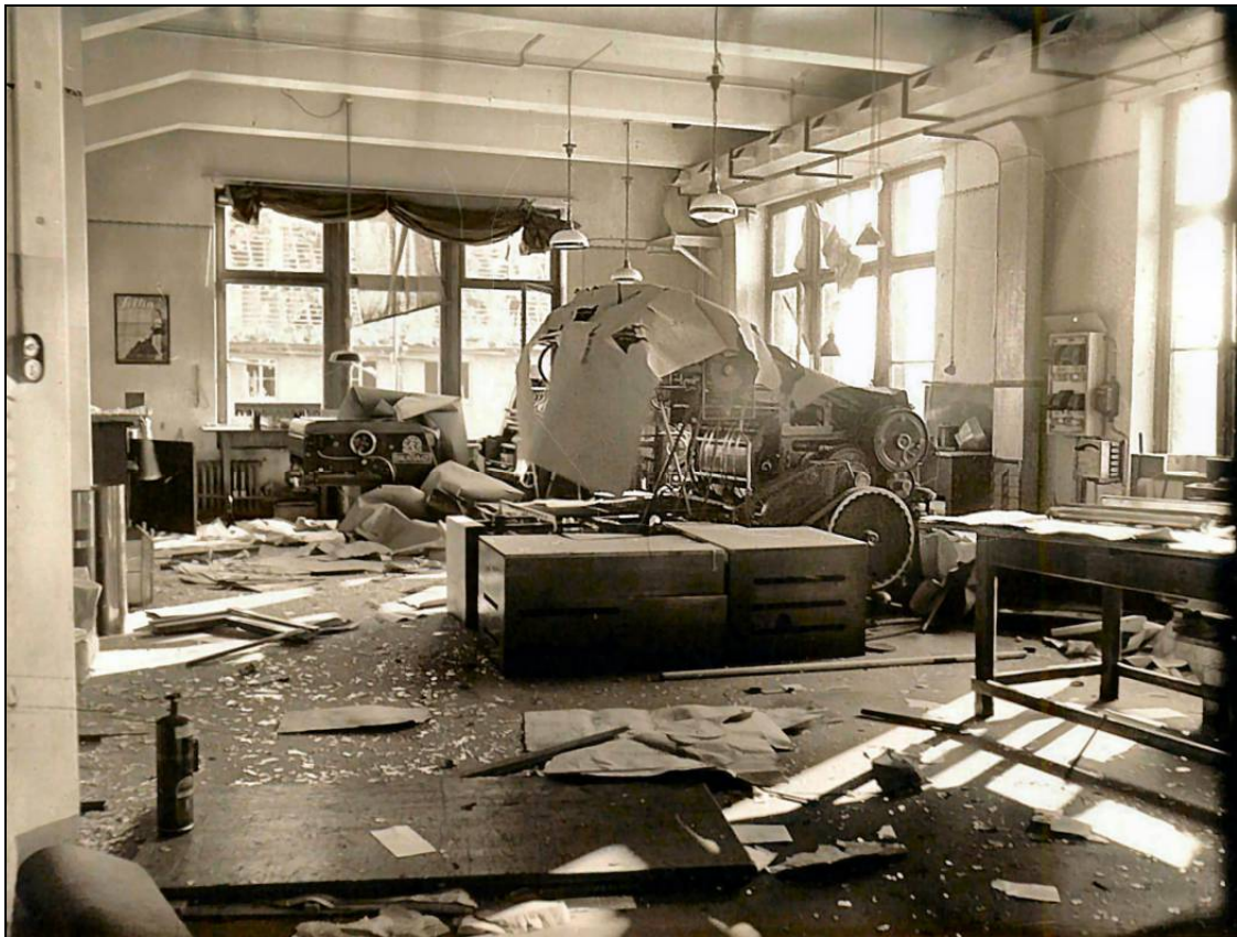
Bild 22: Ein durch eine Druckwelle nach Bombeneinschlag betroffener Maschinenraum
